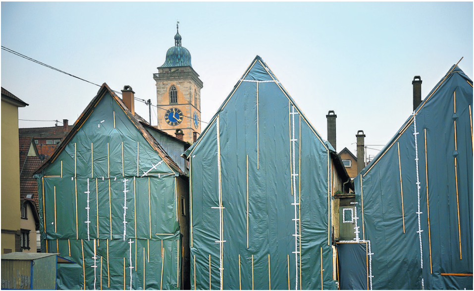
Ein Teil des Ensembles auf dem Heimareal ist abgeräumt und weicht einem Neubau. Diese drei Häuser mit der Stadtkirche im Hintergrund bleiben stehen. Foto: Horst Rudel
